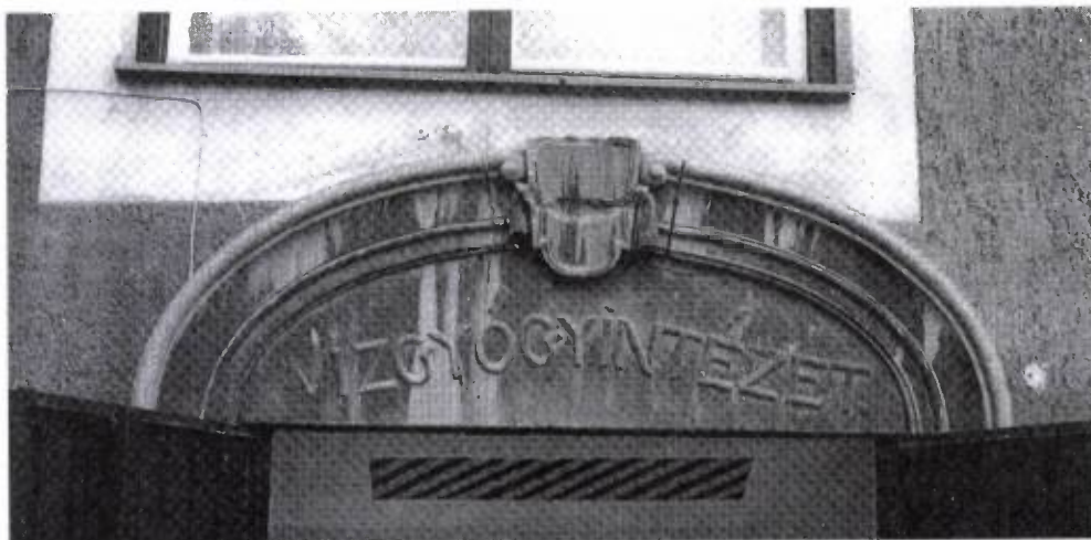
23. kép. A Vízgyógyintézet egykori bejárata.
