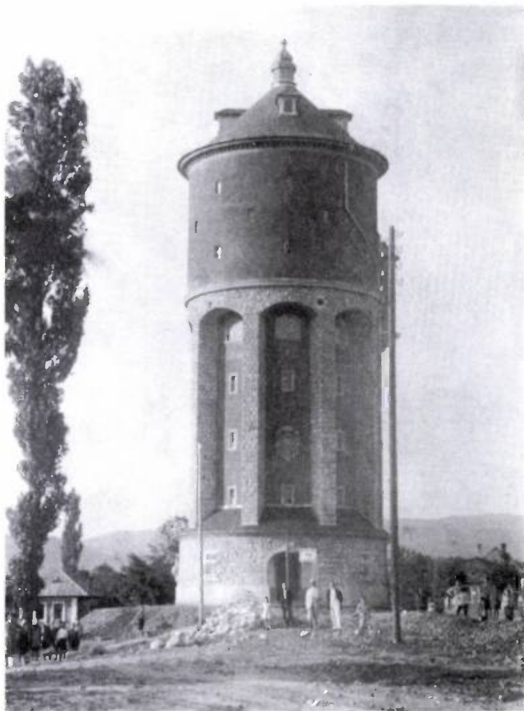
26. kép. A kész épület 1927-ben.
