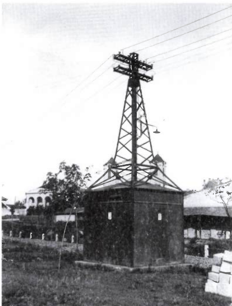
27. kép. A Nádor utcánál álló transzformátor-állomás.
