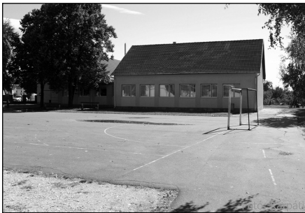
Herman Ottó Általános Iskola és Alapfokú Művészetoktatási Intézmény napközi épületének felújítása
