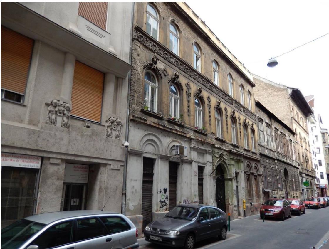
Fig. 1. The façade of 15 Síp utca
