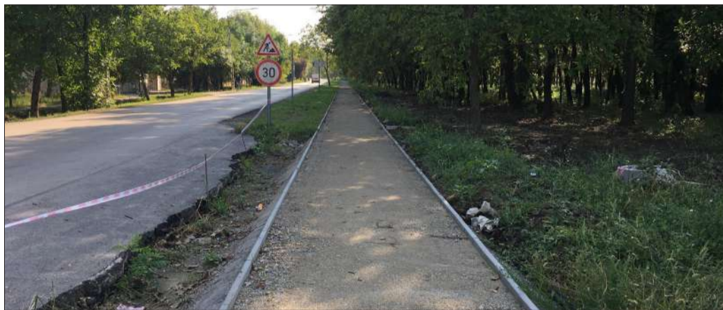
A Körte soron befejezéséhez közeledik az alaprég kialakítása
