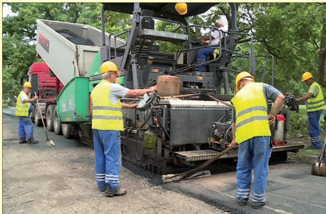
Aszfaltburkolatot kapott a legtöbb utca a felújítás során
