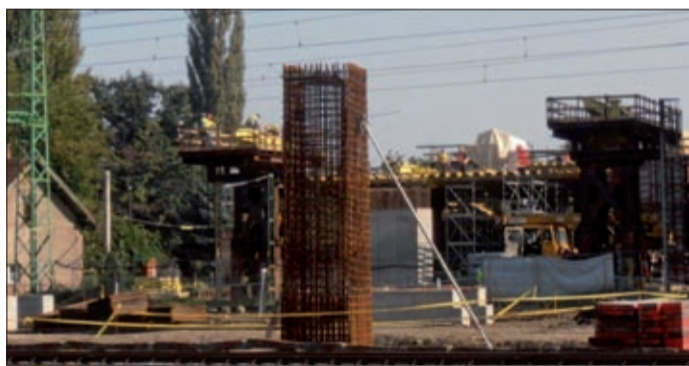
Az Orosházi úti felüljáró építése is jól halad
