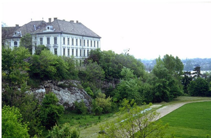
1. ábra. A lelőhely a gimnázium épületével, és az Öreg-tóval. // Figure 1. The site with the school building and the Öreg-tó (Old Lake).
