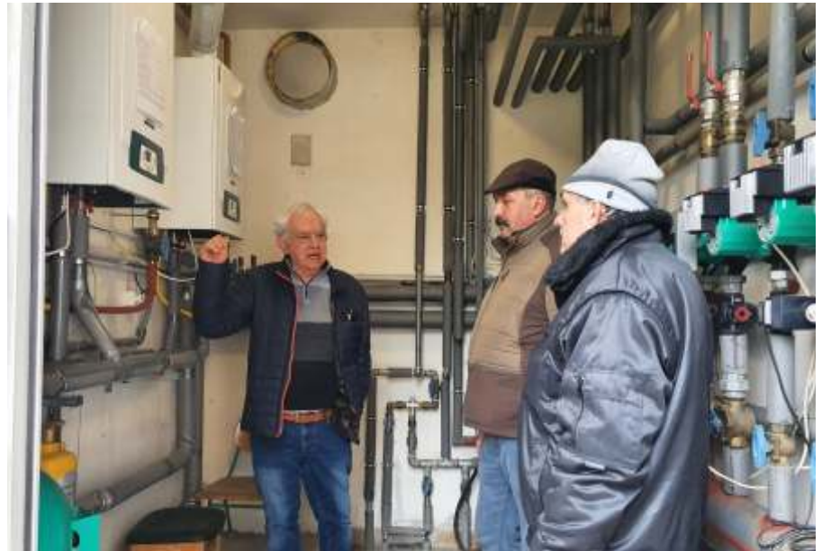
Befejeződött a fűtési rendszer felújítása az Iskola úti fejlesztőközpontban
