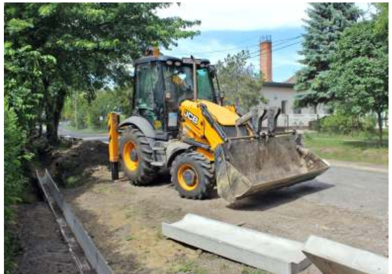
Belvízelvezető csatornaépítés a Kossuth úton (Fotó: Fehér János)
