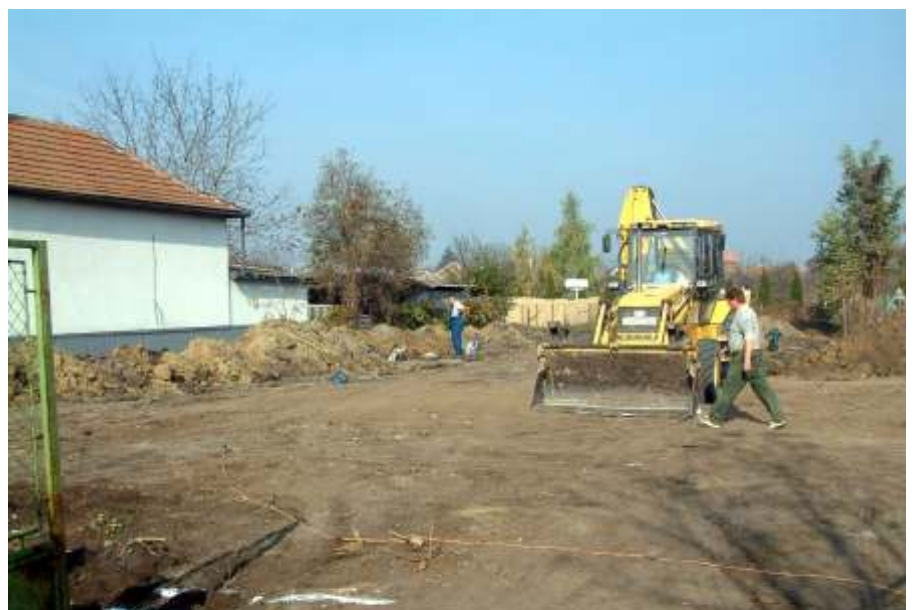
Megkezdődött a bölcsőde építése
