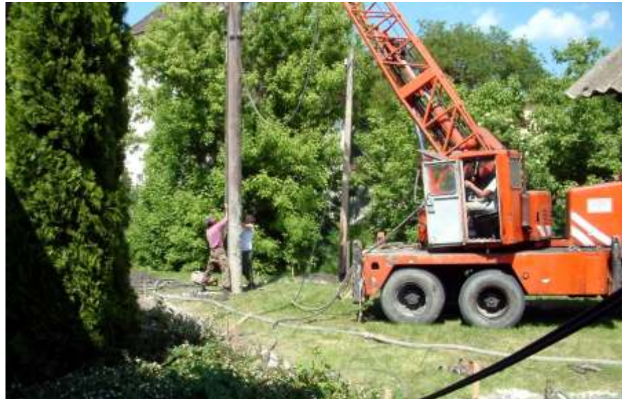
Megkezdődött a Takarékszövetkezet épületének bővítése
