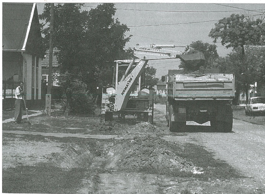
Megkezdődött a Rákóczi út építése
