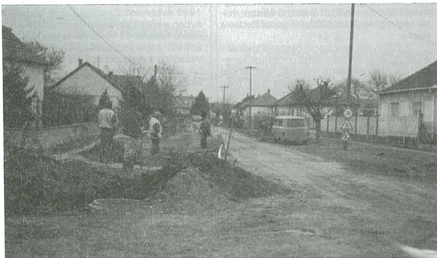
Csatornaépítés az Erzsébet körúton
