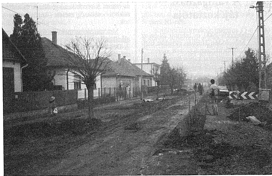
Csatornaépítés az Erkel Ferenc úton
