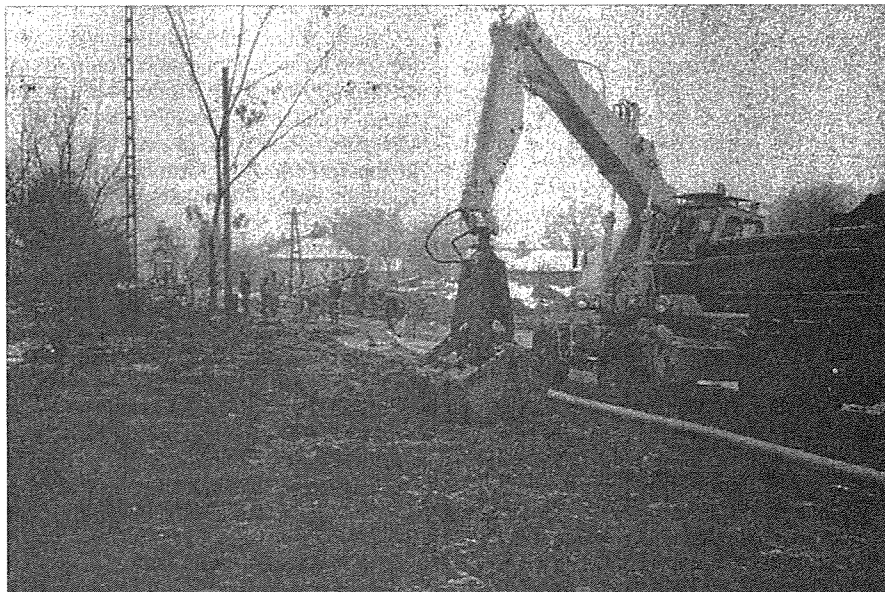
Csatornaépítés a Szekszárdi úton
