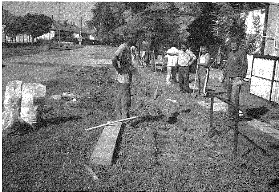
Megkezdődött az árokásás
