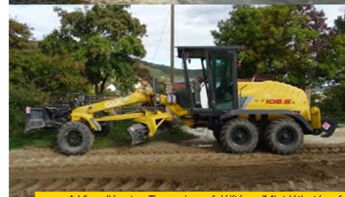
A Vincellér utca Terramix-es felújítása. (Mint látható, a folyamat részeként egy vastag, cementet és kötőanyagot tartalmazó réteget „darál” be az egyik gép az útfelületbe, melyet vízzel permeteztek be, majd hengerelték és marták a felületet.)
