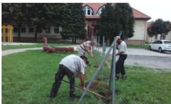
Iskola f bejáratánál kerítés eltávolítása
