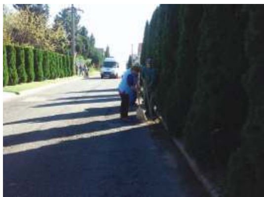
Útpatkák hordaléktól való megtisztítása
