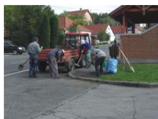
Öregfalusi buszmegálló környezetének felújítása
