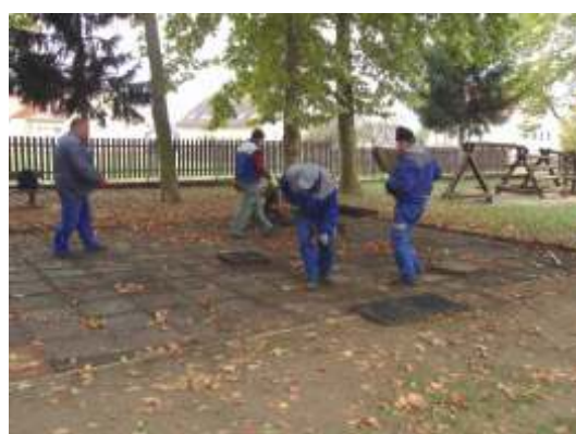
Óvodai felújítási munkálatok elvégzése
