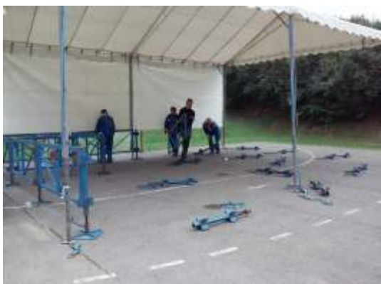
Külső bér munkálatok-(színpad építés)
