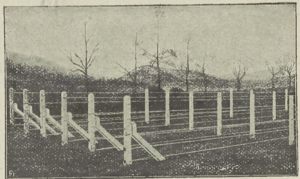
Sodronykeretestelepe egy szőlőnek ORKAN betonoszloppokkal.
