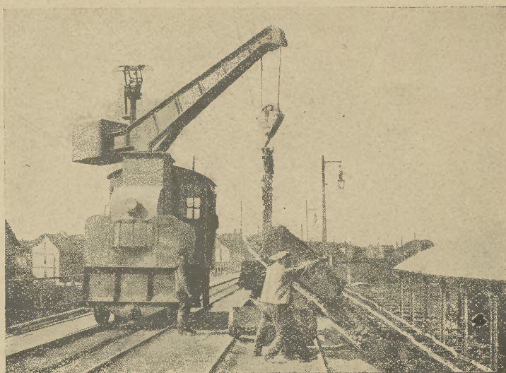
15-ik ábra. A Thomassalak tömbök kiemelése a kocsikból.
