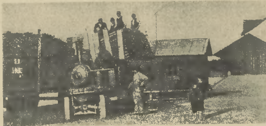
43-ik ábra. Angol gőzmotorkocsi a csehországi Dobzsizsi uradalomban tűzfa szállításra szerelve.
