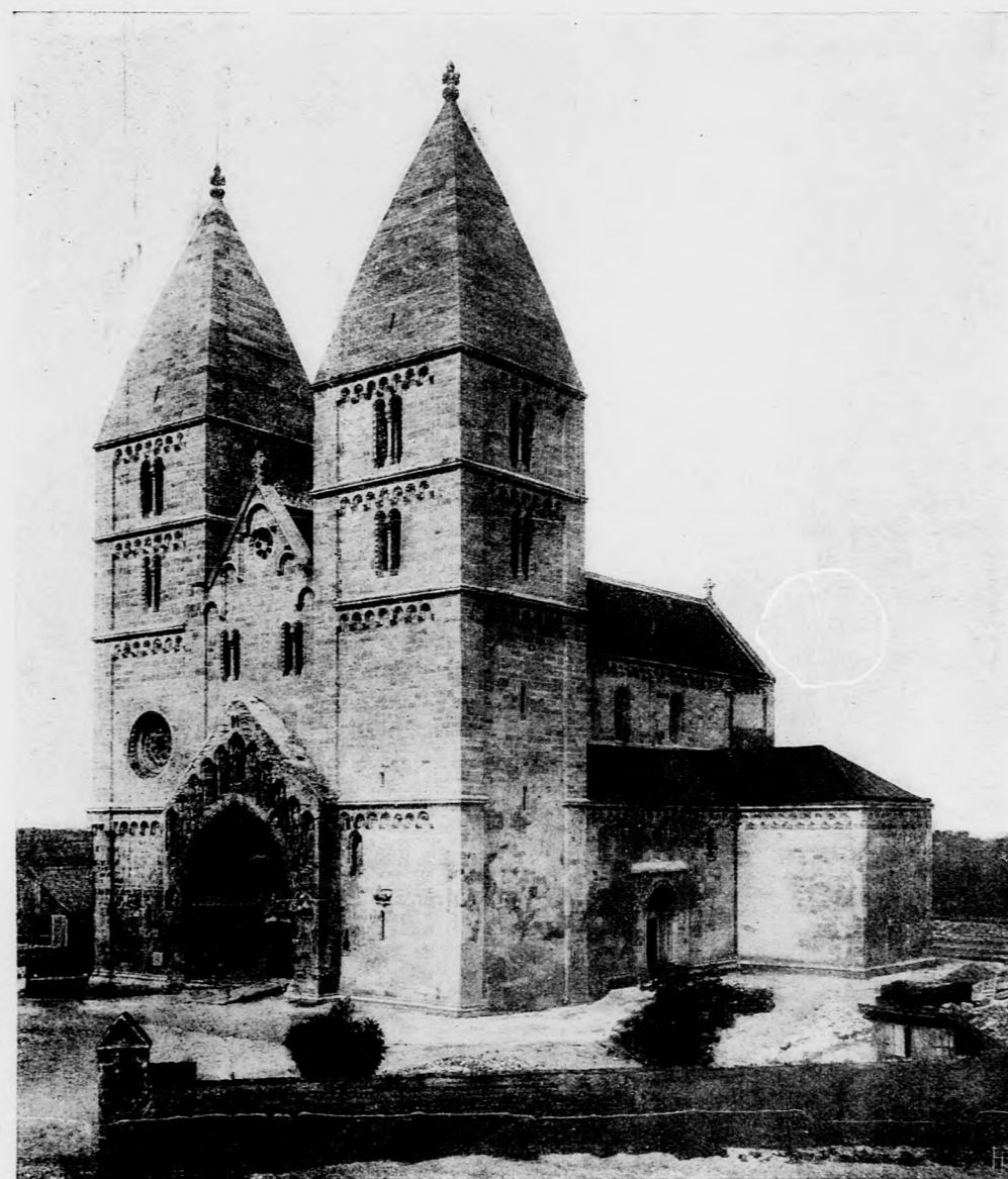
A JAÁKI TEMPLOM AZ UJJÁÉPÍTÉS UTÁN.
