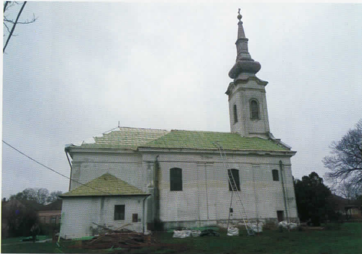
Elkezdődött a katolikus templom és parókia tetőszerkezetének felújítása
