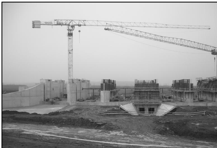
A beeresztő műtárgy (zsilip) építése Tivadar és Tarpa között
