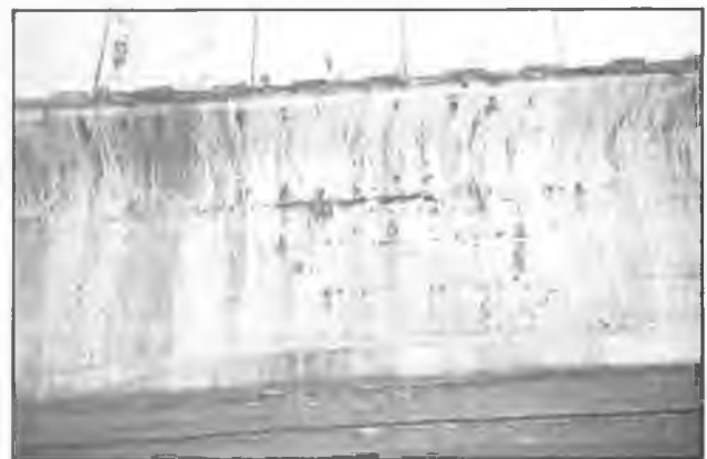
8. ábra. A gerincen kirajzolódó szerelővasak (2000. nov. 13.)
