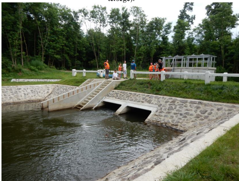
5. ábra. Ikeráteresz, zsilipes fenékgát csónakcsúszdával (Sonkád térsége).
