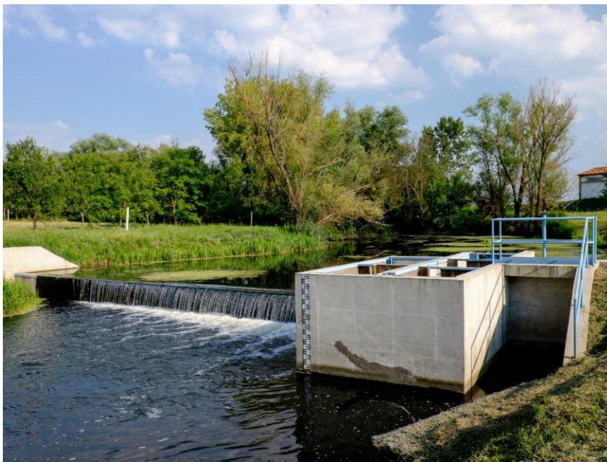
4. ábra. Pengefalás duzzasztó műtárgy hallépcsővel és fenékleürítő zsilippel (Nábrád térsége).
