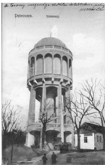
A Leveles-csárda mellett felépült nagyerdei víztorny
