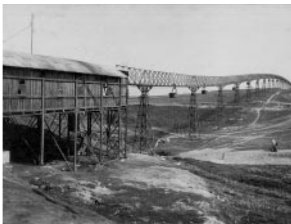
4. kép: Az 1905-ben épült felsőgallai osztályzómű
