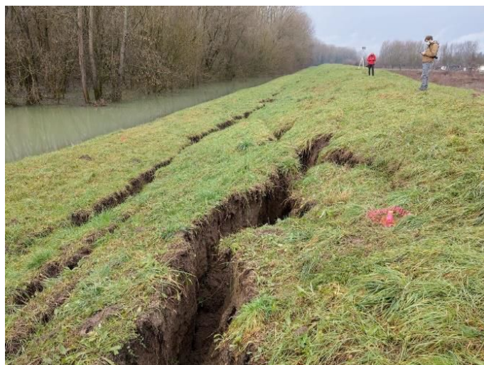
3. ábra. Talajfolyósodás miatt bekövetkező talajszétcsúszás a Száva folyó töltésén (Tomac et al. 2021)
