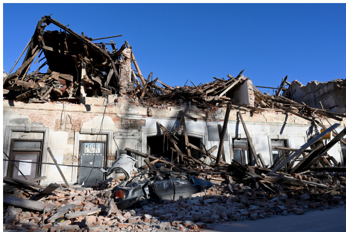
1. ábra. Súlyosan károsodott épület Petrinjában (forrás: https://www.dw.com/en/a-dw-reporter-experiences-croatia-earthquakes-firsthand/a-56104971 (2022.04.12))
