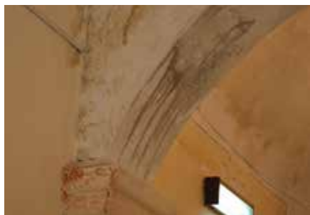
A boltív restaurálás után
