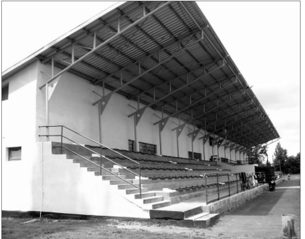
Megtörtént a sérült, hiányos hullámlemez borítás teljes cseréje
