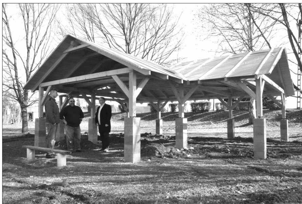
Az Éden-tónál egy 65 m 2 alapterületű, fa tartószerkezetű filagória épül, amely térköburkolatot kap
