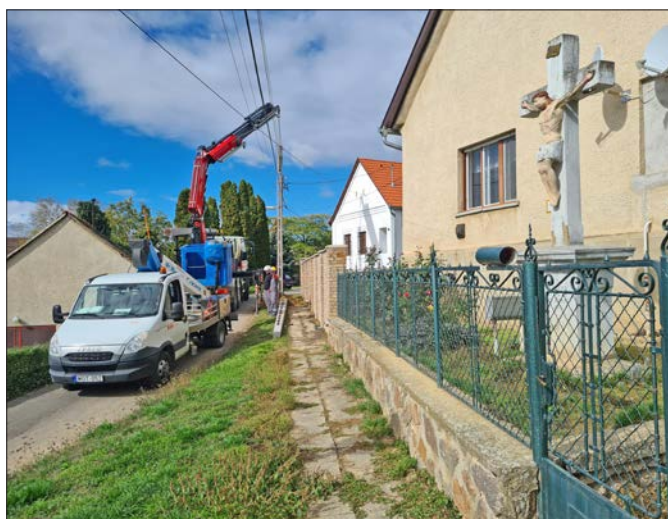
A Hunyadi utcában és a Templom utcában az E-ON a fa villanyoszlopok kiváltásával korszerűsítette a közvilágítást
