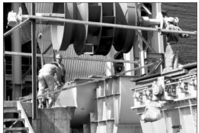
■ 7. ábra. A ventilátorok szerelése
