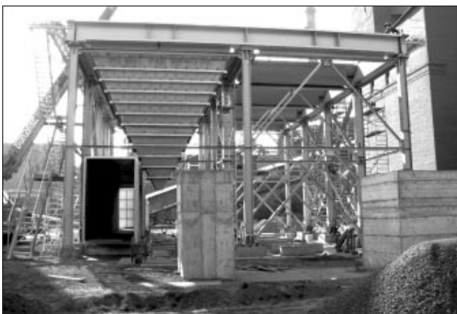
■ 6. ábra. Az első porbunker beépítése
