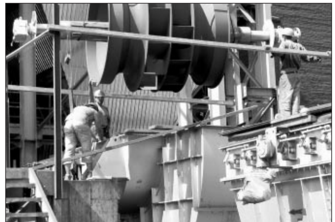
■ 7. ábra. A ventilátorok szerelése
