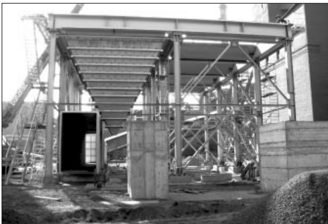
■ 6. ábra. Az első porbunker beépítése
