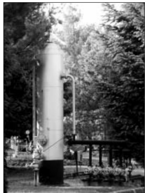
2. kép: Gáz-olaj szeparátor befutósorral és gázmérőhíddal
