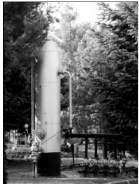
2. kép: Gáz-olaj szeparátor befutósorral és gázmérőhíddal
