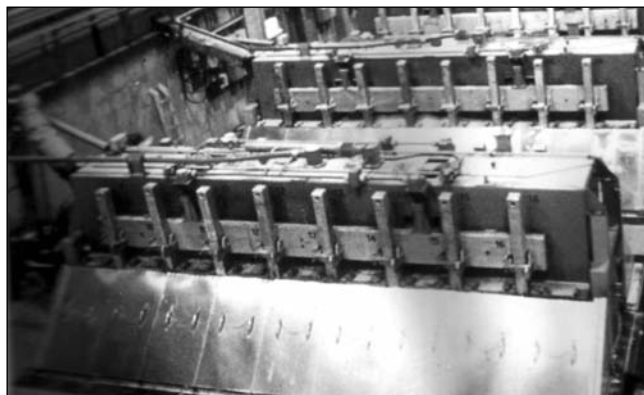
■ 3. ábra. A blokkános technológia a felsőtűskés kohó átalakítása után
