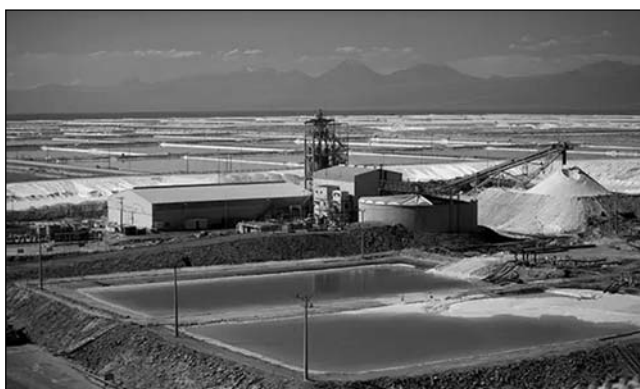
2. ábra. A chilei Atacama sivatagban közel 50 km 2 területre kiterjedő medencékben bepárlódó sókból a Sociedad Química y Minera de Chile (SQM) állít elő tiszta lítium-karbonátot és tiszta lítium-hidroxidot [1]
