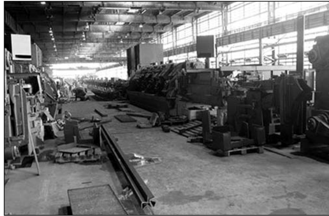
■ 8. ábra. A telepített drótsori hengerállványok, háttérben a víz-hűtő szakasz
