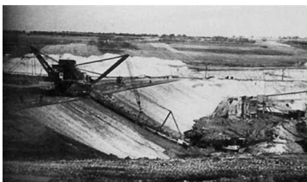
5. fotó: A rózsai völgyben a fedő meddőben vonóvedres kotrók, a szén kiskotrók termelik (1971)
