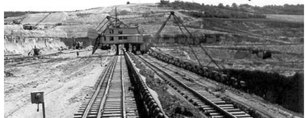
1. fotó: VM-1 vonóvedres kotró rukkolható 1000 mm-es szalaggal (1963)
