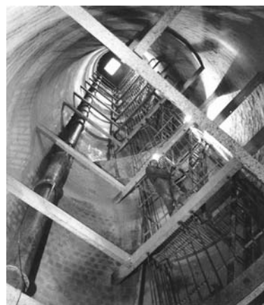
4. ábra: A lemélyített függőleges akna szerelvénye
