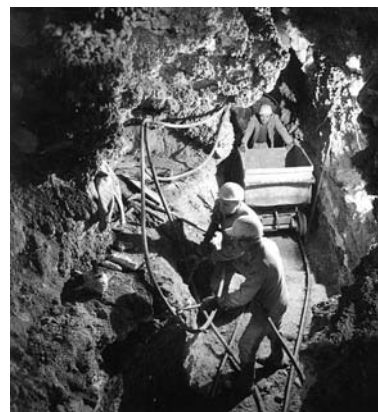
5. ábra: Áttöréskészítés kézi munkával a látogatható szakasz kiképzése idején
