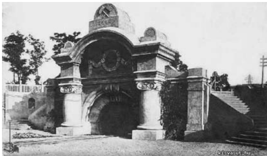
7. ábra: A Tokod-altáró bejárata a felszentelése idején
