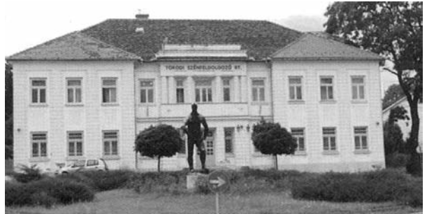
9. ábra: A MÁK Rt Tokodaltárói Igazgatósági épülete (később a Tokodi Szénfeldolgozó Rt. irodaháza lett)
