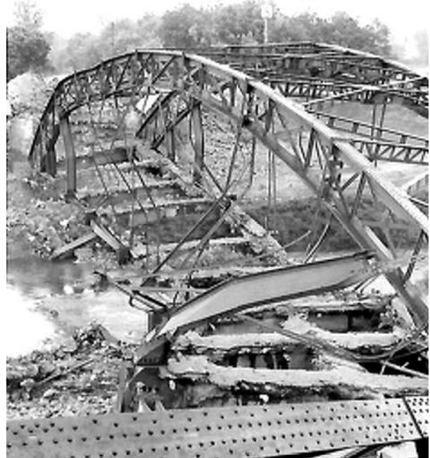
6. kép: Acélszerkezetű hid bontása robbantással
