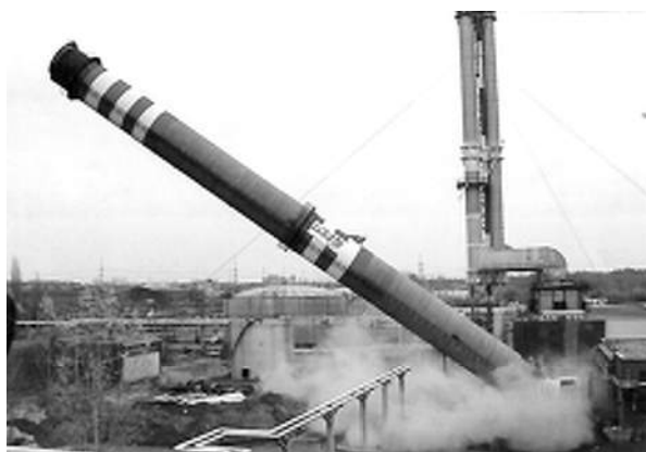
9. kép: 80 m magas kémény robbantása a kispesti erőműben
