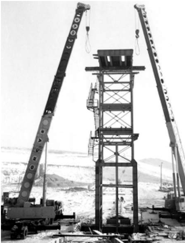
4. kép: Aknatorony beemelés
