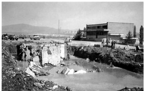
11. kép: A hajmáskéri tárolók vízpuffer alatti robbantása
