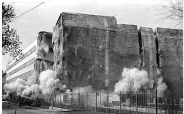
2. kép: Épületrobbantás a Siemens gyár irodája mellett
