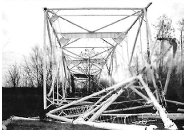
7. kép: Acélszerkezetű oszlop döntése robbantással
