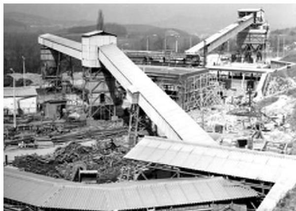
3. kép: Az épülő Nagyegyházi Bányáüzem
