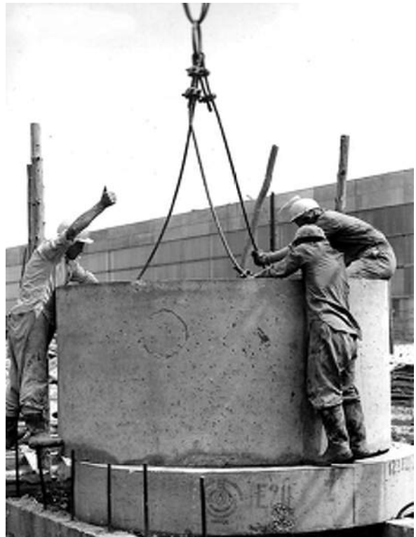
4. kép: Aknaelemek illesztése
