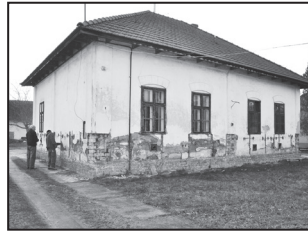
Megkezdődött a volt kántorház felújítása
