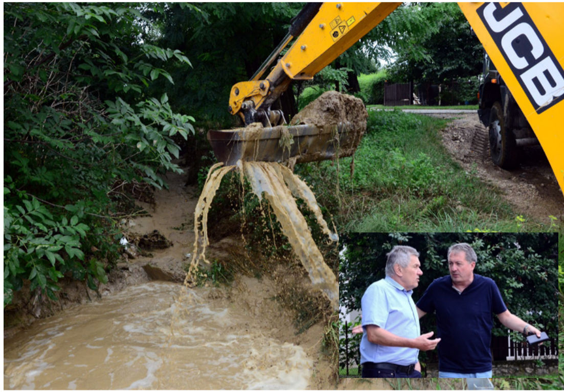
Nagy teljesítményű munkagépekkel bővítették az árokrendszert
