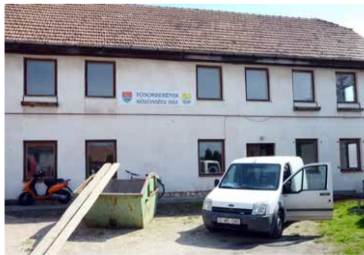
A napokban kezdődött meg a munka a felújításon
