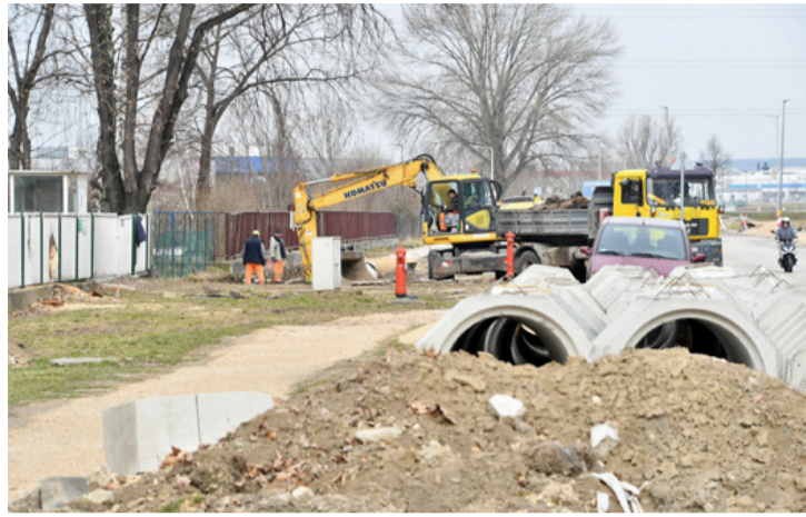
A Civil Ház felőli oldalon készülnek az építők a csövek lefektetésére (Fotó: Györkös)
