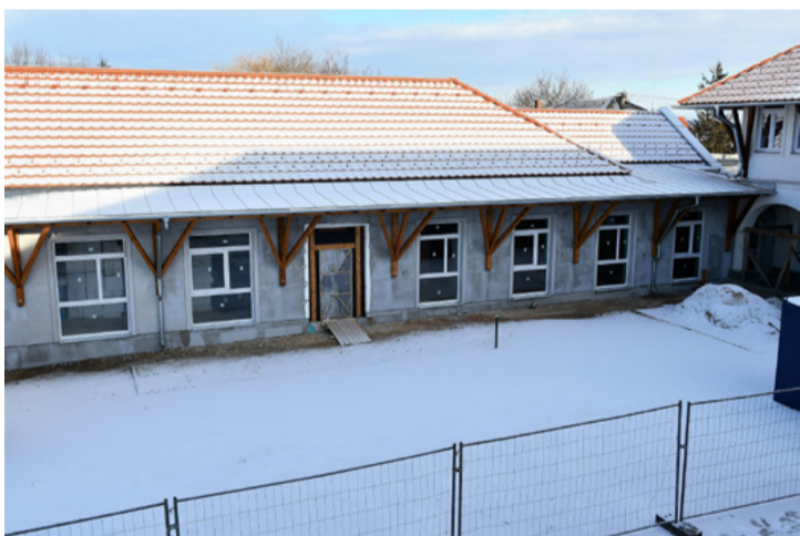
Az épülő étterem külső látképe. A szerelők a belső munkákon dolgoznak
